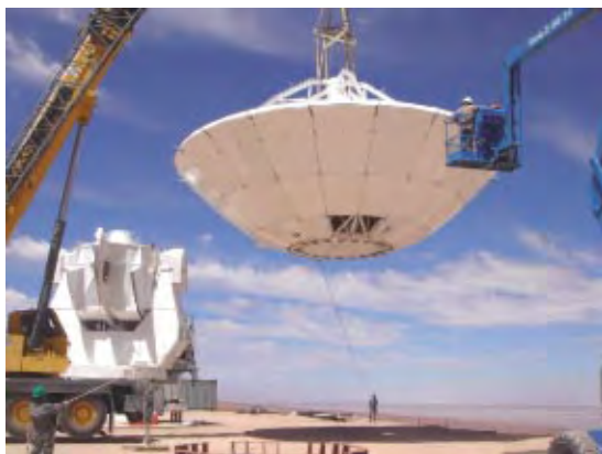
図1 . 主鏡部を架台部へ吊(つ)り込む様子
