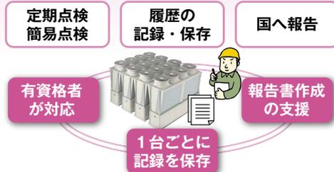
所有者(管理者)には、3ヶ月に1回以上の簡易点検、3年に1回以上の有資格者等による定期点検、履歴の記録・保存、国への報告がフロン排出抑制法で義務付けられています。
