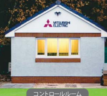
コントロールルーム
