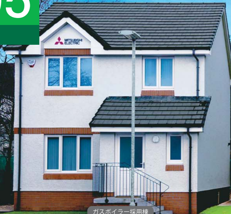
ガスボイラー採用棟
