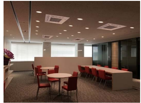
4方向天井カセット形 <コンパクトタイプ> 設置イメージ
