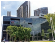
タイFAセンター Thailand FA Center MITSUBISHI ELECTRIC FACTORY AUTOMATION (THAILAND) CO.,LTD
