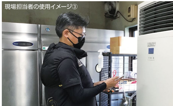
Bluetooth®通信により、リモコンから試運転データを取得
