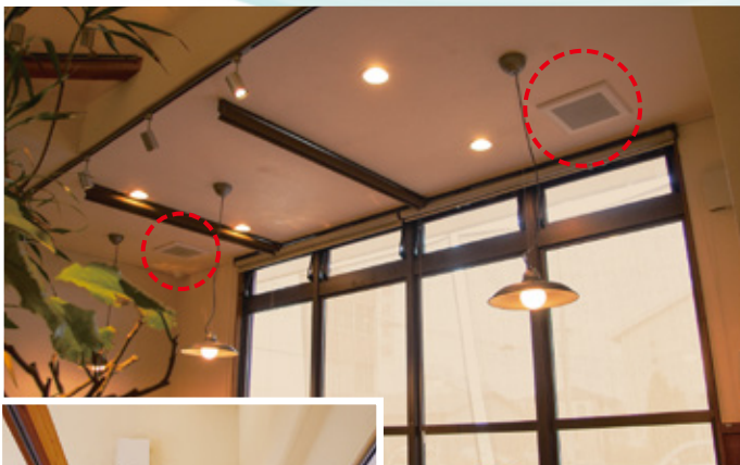
テーブル席 (4人掛け×3卓) にダクト用換気扇DCタイプを2台採用
