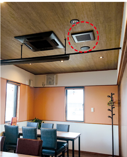
開店時に新たに設けた個室。こちらのダクト用換気扇(ACタイプ)も今回更新した
