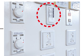
スマートスイッチは厨房の壁面に。隣のロータリースイッチは天井扇用
