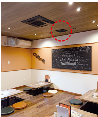
小上がり席のダクト用換気扇(ACタイプ)も更新。三菱電機製の空調機も好評
