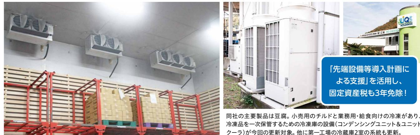
同社の主要製品は豆腐。小売用のチルドと業務用・給食向けの冷凍があり、冷凍品を一次保管するための冷蔵庫の設備(コンデンシングユニット&ユニットクーラ)が今回の更新対象。他に第一工場の冷蔵庫2室の系統も更新。
