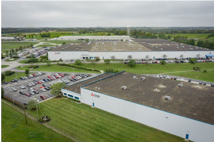
転用予定の米国製造拠点 外観
